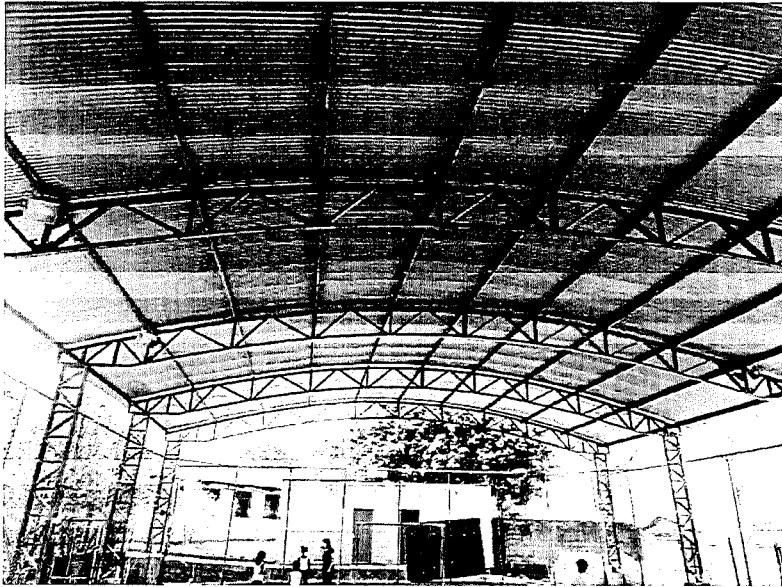
Foto – Vista da Quadra – Será retirada as telhas e será lixadas e pintada a estrutura metálica
