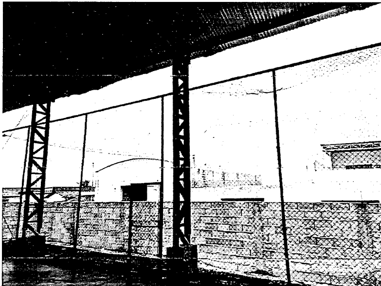
Foto – Serão retiradas as telhas – e pintada toda estrutura metálica inclusive os pilares.
